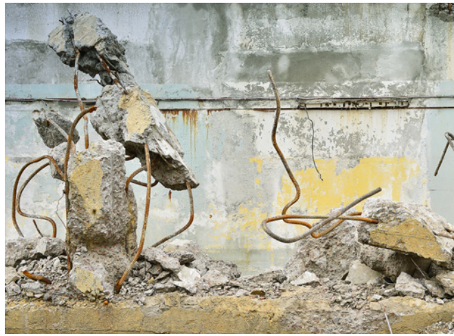
Demolición de hormigón
